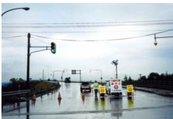
写真 - 3 国道336号十勝河口橋の通行止め
