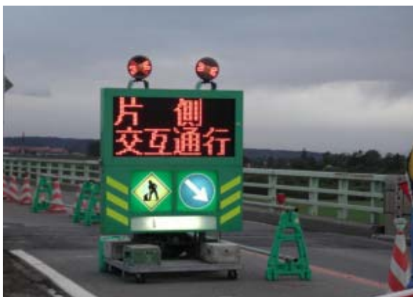
写真 - 2 国道242号千代田大橋の通行規制
