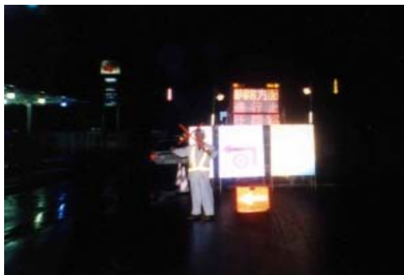
写真 - 1 国道38号の通行止め
