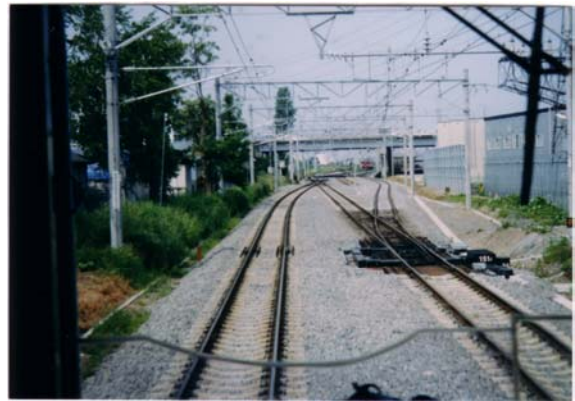
写真2 旭川限度額立交機能補償工事で実施された本線の複線電化終点（線路がうねっているため新駅設置の余地がない）
